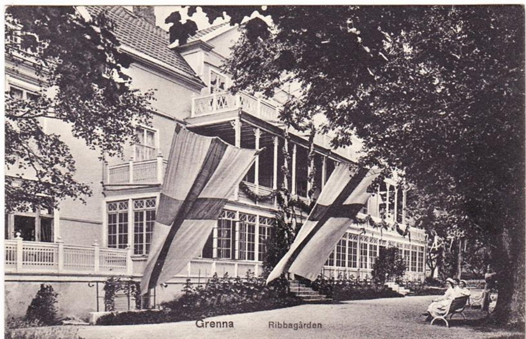
Bild 7. Gränna. Ribbagården. - från söder med stor veranda och balkong.
