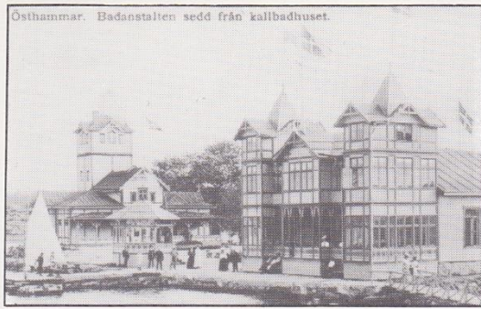
Östhammar. Badanstalten sedd från kallbadhuset.
